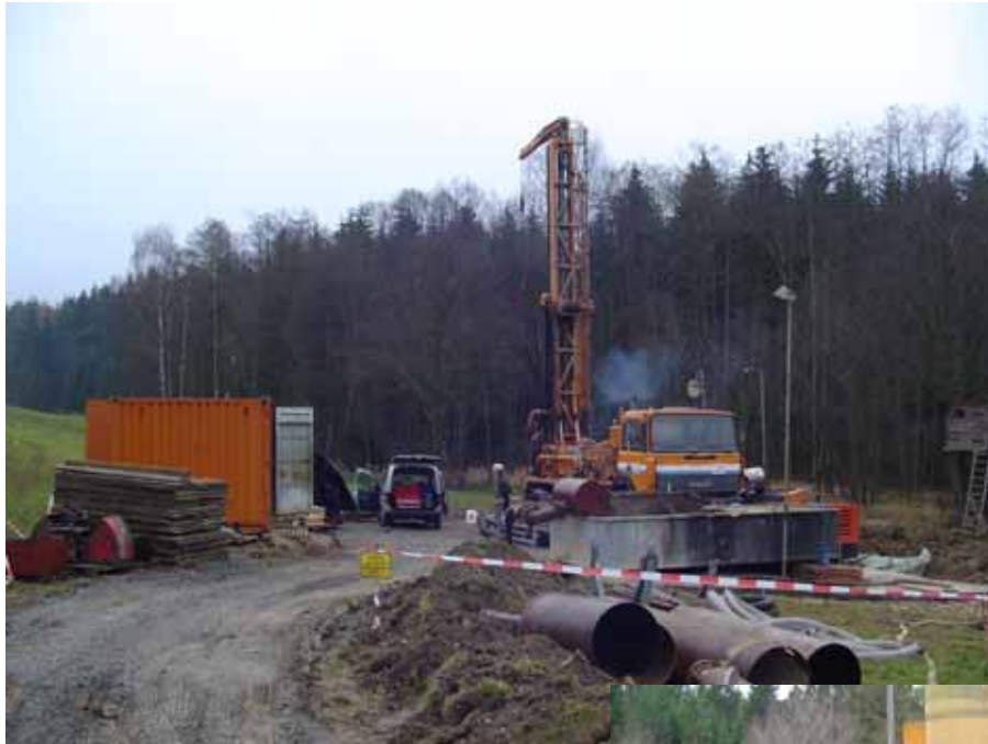
Bohrplatz mit Bohrgerät
