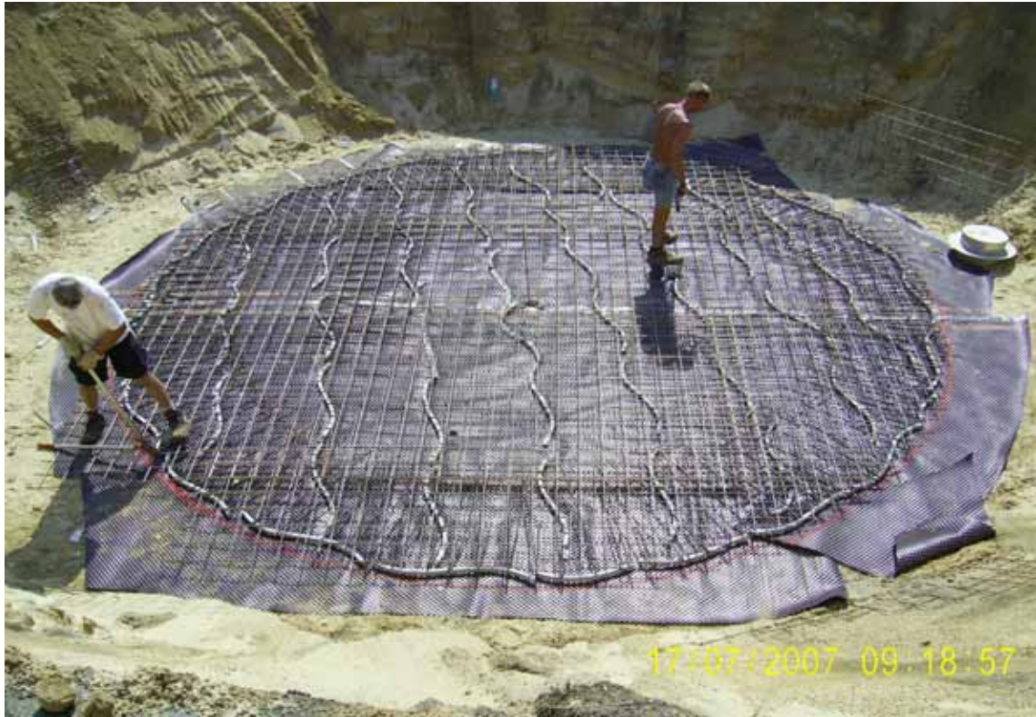
Herstellung Bodenplatte Löschwasserbehälter Stahlbetonbau 75 m 3 Fassungsinhalt
