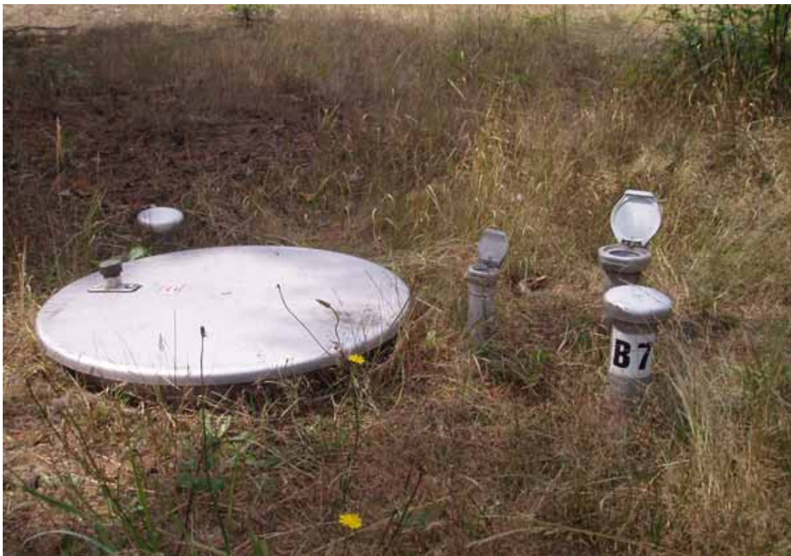
Haltungsbrunnen GW-Sanierung Zerze
