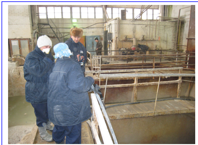
Blick in die zu ertüchtigende Pumpenstation
