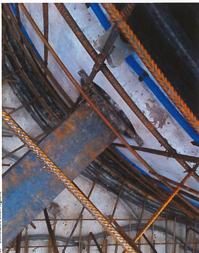
Abb. 3 – Bewehrung des Auftriebsfundaments mit HEA-Trägern zur kraftschlüssigen Anbindung des Senkschachtes (HBr P I. bei Riesa)
