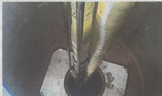
Blick in den Brunnenschacht mit Bohrloch während der Einbauarbeiten.
