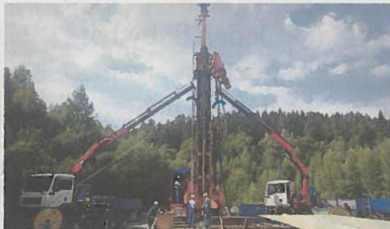
Impression vom Einbau des Förderequipments in die Solebohrung.
