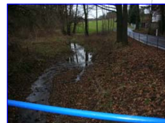
Durchlass 2 und Friesenbach
