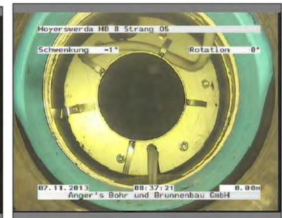
➤ Kabelführung außerhalb der Filterstrecke
