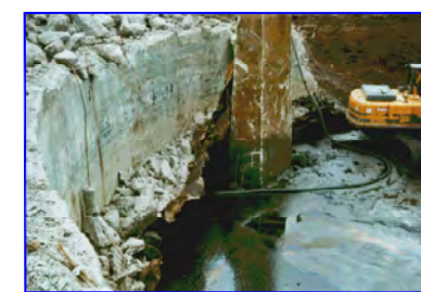
Abpumpen des kontaminierten Wassers
