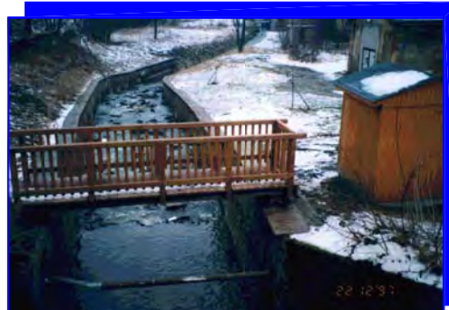
Pegelhäuschen mit Meßsteg
